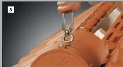
Der überstehende Firstklammerdraht wird oberhalb der Klemmkralle mit einer Zange gekürzt.
