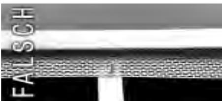
Aluminium ist ein Werkstoff mit einem hohen thermischen Ausdehnungskoeffizienten. Ordnet man Elemente wie beispielsweise UK-Profile und Al-Lüftungsgitter oder Al-Sichtblenden an durchlaufenden Fensterstürzen im rechten Winkel zueinander an, so muss **zwingend** konstruktiv dafür gesorgt werden, dass bei Tempe-
