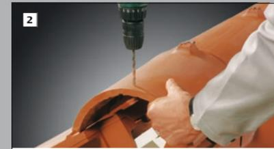
Der Firstziegel wird ca. 30 mm vom äusseren Ende mit einem 6 mm Bohrer für die Aufnahme der Funktionsanfang- und -endscheibe durchbohrt.
