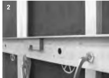
**2** Es wird der Einbau der Fassadentafeln von oben nach unten empfohlen. Hierzu wird die vorbereitete Fassadentafel auf das Richtscheid gestellt und die exakte Fuge mittels Distanzhalter hergestellt.
