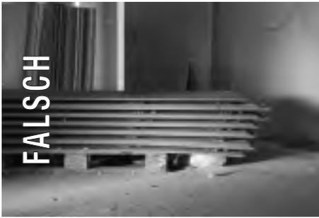
Fassadentafeln aus Faserzement sind auf einer ebenen Unterlage trocken und vollflächig unter einer Baufolie zu lagern.
