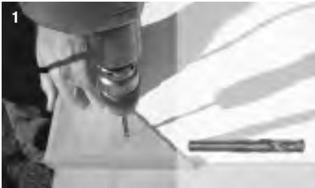
**1** Fassadentafel liegend vorbohren, ggf. Bohrschablone verwenden. Empfohlener Bohrer: Eternit Spezialbohrer für Faserzement  $\varnothing = 9,5$  mm.
