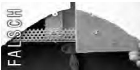
Zwängungsspannungen, hervorgerufen durch Bauteile, die zwischen UK und Bekleidung liegen, sind insbesondere durch konstruktive Maßnahmen zu vermeiden. Die Dicke der hinterlegten Fugenprofile darf 0,8 mm nicht überschreiten. Eine Profilwanderung ist durch einseitige Fixierung zu verhindern. Die Verschmutzungsanfälligkeit wird jedoch durch horizontale Fugenprofile erhöht. Material: Aluminium lackiert, kunststoff- oder pulverbeschichtet. Eine Aufdoppelung der Fugenprofile ist unzulässig.
