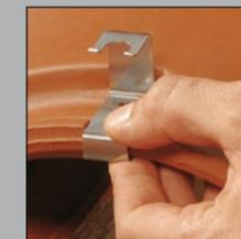
5 Aufstecken der Edelstahl-Firstklammer auf die Verfalzung des Firstziegels.
