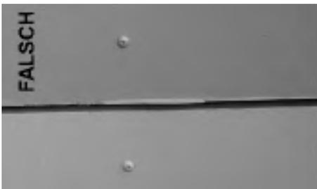
Die Lieferung der Fassadentafel erfolgt grundsätzlich mit Stanzkante. Vor der Verlegung muss die Tafel allseitig 15 mm besäumt und bei Natura, Natura PRO und Pictura mit Lukokantenimprägnierung behandelt werden. Die Stanzkante ist der beim Pressen entstandene Randbereich. Diese Kanten haben nicht die notwendige Festigkeit, können Grate besitzen und brechen beim Verlegen des Materials aus.
