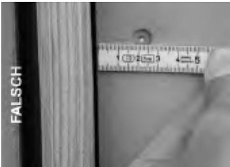
Die Befestigung von Fassadentafeln auf einer Holz-Unterkonstruktion darf keinesfalls mit Senkkopfschrauben erfolgen, denn hierbei bilden sich Festpunkte und das Material kann nicht mehr "arbeiten". Es entstehen Spannungen, die je nach Wirkrichtung zu Rissen führen können. In den Verlegerichtlinien der Eternit AG ist vorgeschrieben, dass die Fassadentafeln mit 6 mm vorgebohrt werden müssen. Die Befestigung darf nur mit Eternit Fassadenschrauben (5,5 x 35 oder 5,5 x 45) erfolgen.
