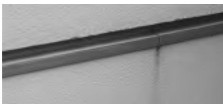
Es wird dringend empfohlen, die horizontalen Fugen zwischen den einzelnen Bekleidungs-tafeln offenzulassen. Bei der Verwendung von Fugenprofilen kann es leicht zur Bildung von Ablaufspuren kommen. Das gilt insbesondere bei Stuhlprofilen. Bei dieser Profilart ist die Fläche, auf der sich Schmutz abgelagern und
