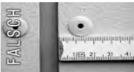
Die Eckbereiche der Bekleidungsplatten sind durch die Belastungen beim Nietsetzen und die Aufnahme von Dehnungsspannungen die am stärksten belasteten Bereiche.
