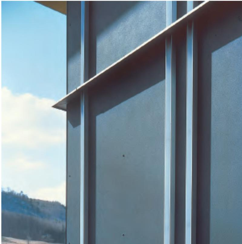
Die Fugengestaltung einer vorgehängten hinterlüfteten Fassade steht in direkter geometrischer Beziehung zu Gebäudekanten und Öffnungen und prägt den gesamten Charakter eines Gebäudes.
