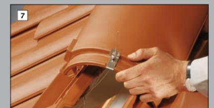
8 Der Draht wird mit der Hand nach oben gezogen (gespannt) und anschließend nach unten abgebogen. Dadurch verkrallet sich der Draht im Führungsschlitz der Firstklammer.
