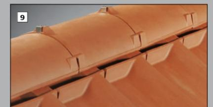
9 Vollkeramischer First mit Firstziegeln und Firstanschluss-Lüfterziegeln.
