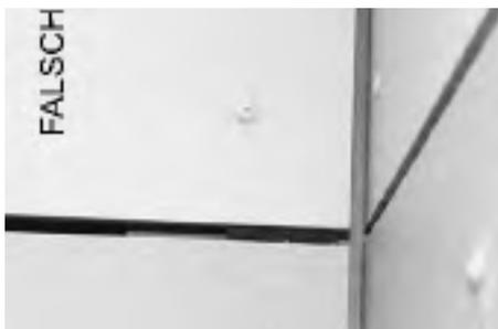
Bei der Verlegung von Faserzementtafeln auf einer Holz-Unterkonstruktion muss die Traglattung durchgehend vor der Witterungsfeuchte geschützt werden. Das Fugenband muss mind. 10 mm breiter sein als die jeweilige Lattung, um ein Eindringen von Feuchtigkeit zwischen Holz und Fugenband zuverlässig zu unterbinden. Das Fugenband kann beispielsweise aus EPDM oder Aluminiumfolie bestehen.
