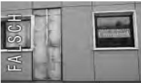
Jede Tafel darf gleichzeitig nur auf Tragprofilen befestigt werden, deren Wandhalter für Festpunkte auf gleicher Höhe liegen. Insbesondere im Fensterbereich muss daher mit getrennten, parallel verlaufenden Einzelprofilen gearbeitet werden, um unzulässige Spannungen zwischen UK und Bekleidung auszuschließen.
