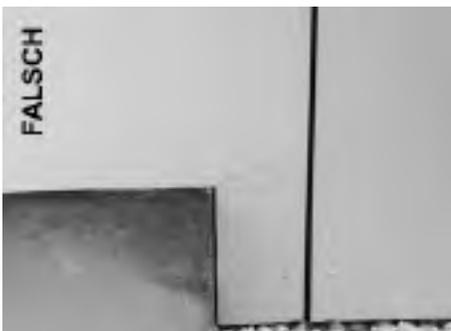
Ausklinkungen bei Faserzementtafeln sollten nicht in einem scharfen Winkel erfolgen. Scharfkantige Ausschnitte bilden so genannte Kerbstellen, die häufig ein Ausgangspunkt für Rissbildungen darstellen. Einmal entstandene Risse "wachsen" mit der Zeit und die Folge kann Materialbruch sein. Das Risiko des Auftretens der Kerbrisse kann verringert werden, wenn beim Ausklinken an der Ecke eine Bohrung gesetzt wird und so eine leichte Abrundung geschaffen wird.
