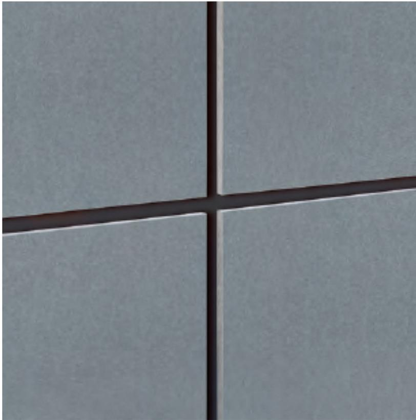
Die Klebertechnik ist eine Möglichkeit zur Fassadengestaltung mit rückseitiger nichtsichtbarer Befestigung von Fassadentafeln aus Faserzement auf einer Unterkonstruktion aus Aluminium.
