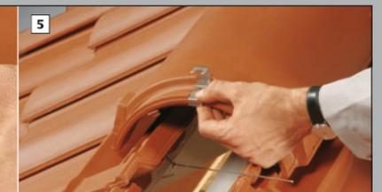
6 Die Edelstahl-Firstklammer kann beim Montieren durch ihre Passgenauigkeit und Federkraft nicht mehr vom Firstziegel abfallen.
