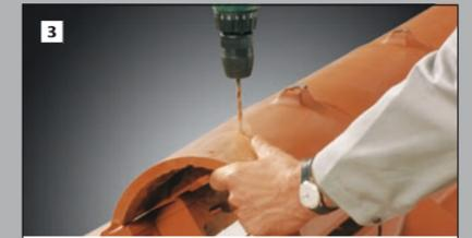
Das Pastsstück wird am Scheitelpunkt im äusseren Drittel für das Aufnehmen des zusätzlichen Firstklammerdrahtes gebohrt (6 mm Bohrer).
