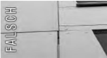
Das Fugenbild hat großen Einfluss auf die Erscheinung einer Fassade. Die Fugenbreite sollte in der Regel zwischen 8 - 10 mm liegen. Millimetergenaues Vorbohren der Tafeln, exaktes Aufmaß und die Nutzung von Fugenlehren sind Voraussetzung zur Erzielung eines gelungenen Erscheinungsbildes.
