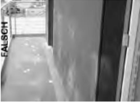
Schneid- und Bohrstaub muss umgehend trocken abgewischt werden. Am besten eignen sich hierzu Microfasertücher, durch ihre speziellen Fasern nehmen sie Staub besonders gut auf. Schneidstaub von erhärtetem Zementstein besitzt wieder reaktionsfähige Oberflächen. Wenn dieser Staub mit Regen oder Tau in Kontakt kommt, bildet er auf der Sichtseite einen festen Belag, der je nach Intensität nur aufwändig oder teilweise gar nicht mehr entfernbar ist.
