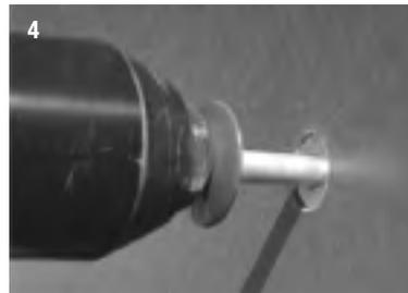
**4** Fassadenniet setzen. Darauf achten, dass der Nietkopf plan anliegt. (Foto zeigt Niet mit Festpunkthülse = Festpunkt). Bei den Fassadentafeln Natura PRO und Pictura ist beim Setzen des Nietes die Eternit Nietsetzlehre PRO zu verwenden.
