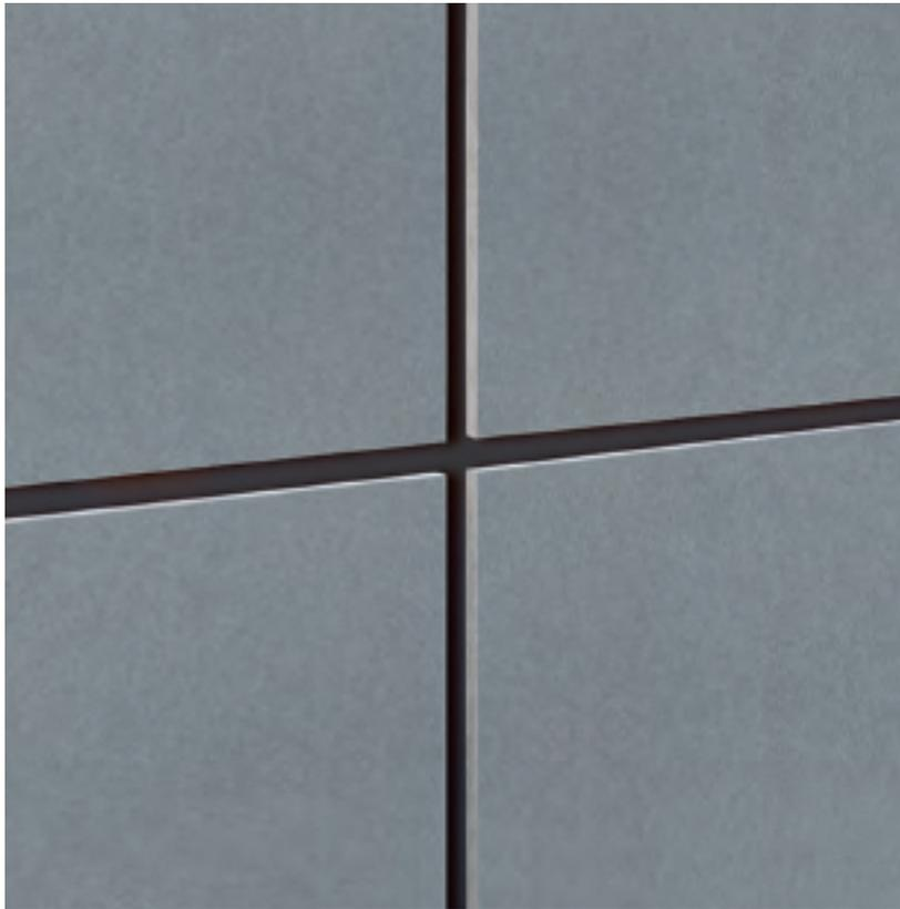
Eternit-Tergo ist ein Fassadengestaltungslösung zur rückseitigen, nichtsichtbaren Befestigung von Eternit Fassadentafeln aus Faserzement auf Unterkonstruktionen aus Aluminium. Das System umfasst neben den hochwertigen, individuell zugeschnittenen und mit hinterschnittenen Bohrlöchern versehenen Fassadentafeln auch die speziellen Eternit-Hinterschnittdübel mit passenden Schrauben und Unterlegscheiben, bzw. Eternit Hinterschnittniete mit passenden Distanzscheiben.
