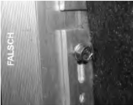
Bei der Verbindung der Bauteile der Aluminium-Unterkonstruktion muss sicher gestellt sein, dass die notwendigen Gleitpunkte auch uneingeschränkt funktionsfähig als solche ausgebildet sind. Montagefehler an der Unterkonstruktion, die zu Spannungen im Gesamtsystem der Fassade führen, haben notwendigerweise auch einen negativen Einfluss auf die Fassadenbekleidung.
